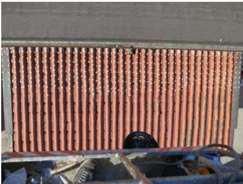
Figura 5. El área del tejado sur tratada con Bird Free fue de aproximadamente 9m x 1.8m.
