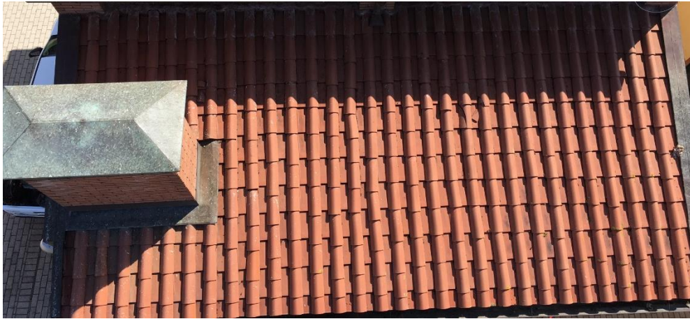
Figura 8. Tejado norte después de la limpieza.
