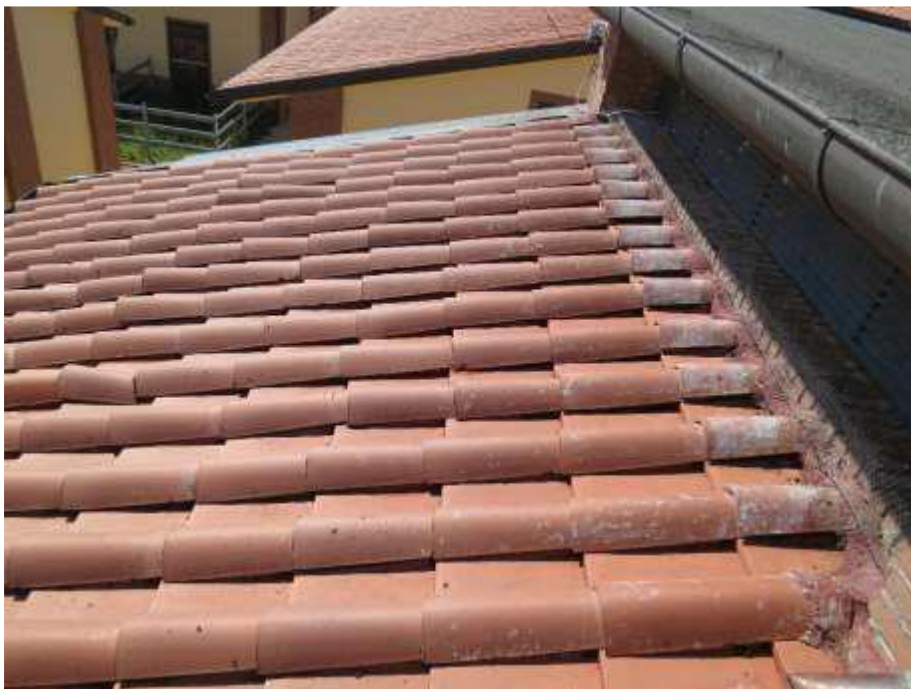
Figura 3. Tejado sur después de la limpieza.
